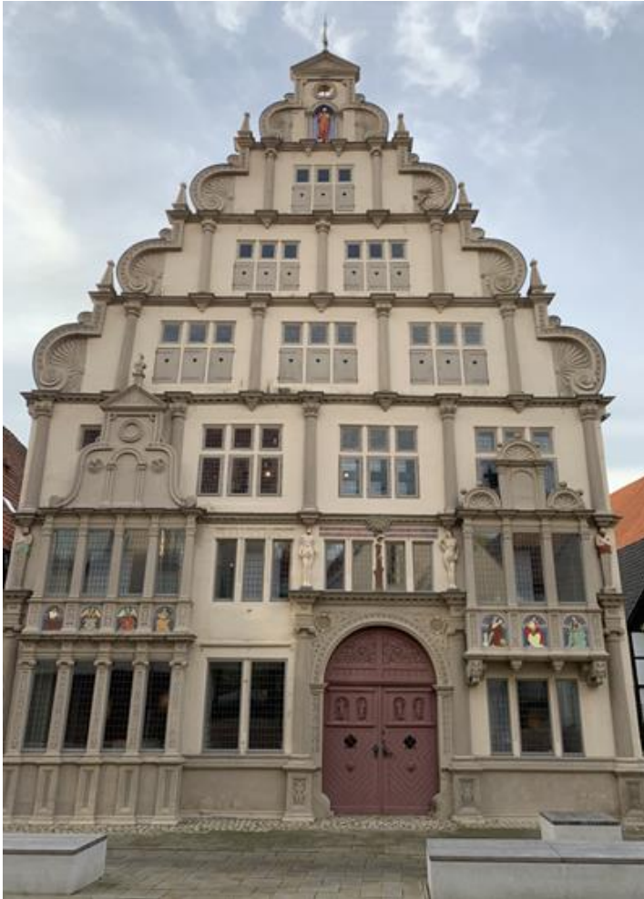
Abb. 1: Haus Kruwel, Hauptfassade, Foto: © Mandy Berger-Bringsken (2021)
