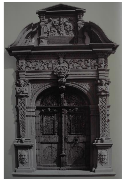
Abb. 25: Hauptportal des Freulerpalastes, Foto: © Peter Ringger (1989)
